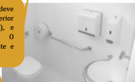
FIGURA 2 – BANHEIRO ADAPTADO A PESSOAS COM DEFICIÊNCIA
